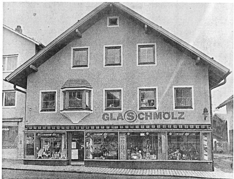
Und so sieht das Geschäftshaus der Firma Glas-Schmölz heute aus.
